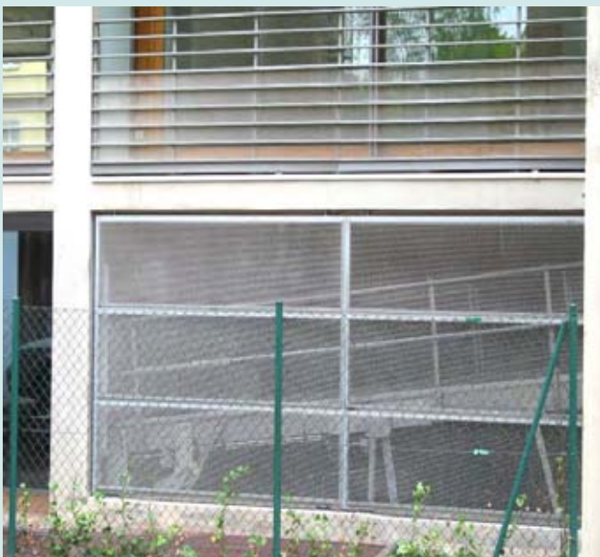
rotec-Streckgitter als Balkonverkleidung sowie Wandverkleidung eingefasst im Einfassprofil Typ E aus Edelstahl 1.4301
