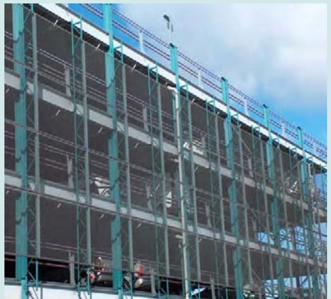
rotec-Streckgitter als gestalterische Fassade für ein Parkhaus im Rahmenprofil eingefasst und nachträglich feuerverzinkt
