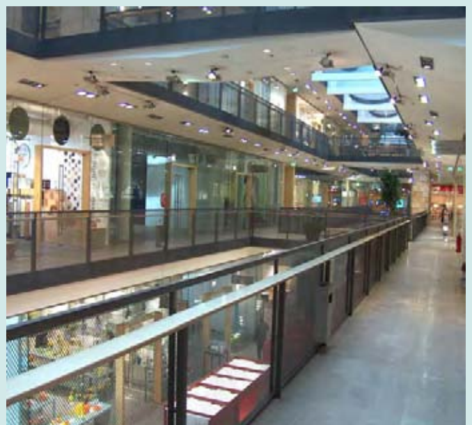
rotec-Streckgitter mit Quadratmasche, eingefasst im Rahmenprofil als Geländerfüllung und nachträglich pulverbeschichtet
