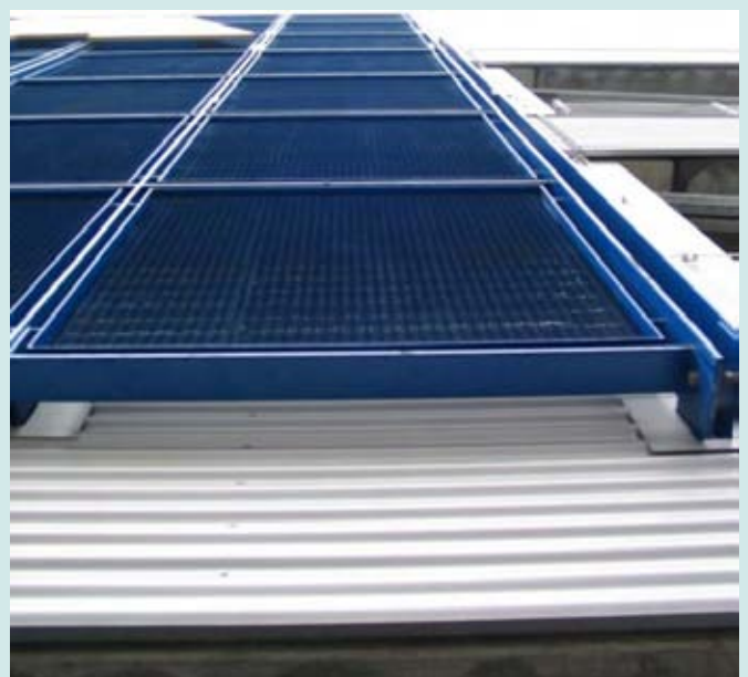
rotec-Streckgitter als Fassadenverkleidung eines Parkhauses eingefasst im Winkelrahmen und nachträglich pulverbeschichtet
