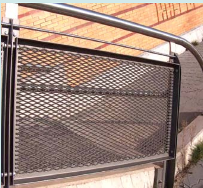
rotec-Streckgitter als Geländerfüllung sowie Vogelschutz einer Brückenanlage im Winkelrahmen eingefasst und nachträglich pulverbeschichtet
