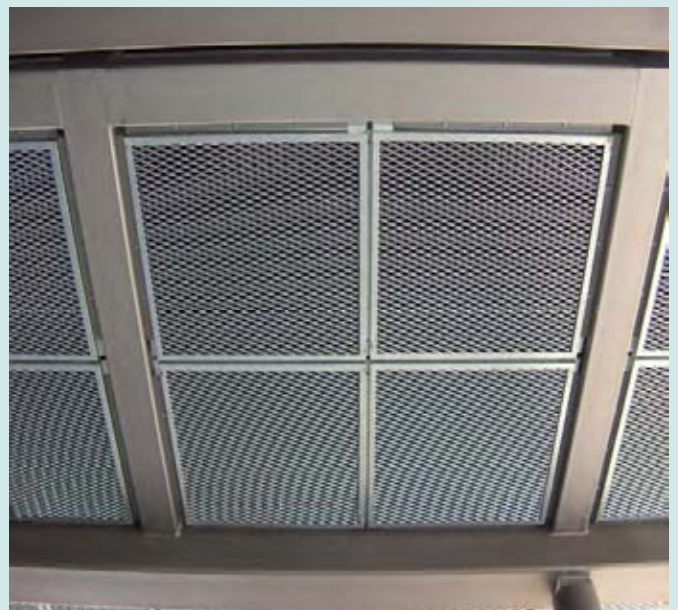
rotec-Streckgitter als Deckenverkleidung im Winkelprofil eingefasst und nachträglich feuerverzinkt
