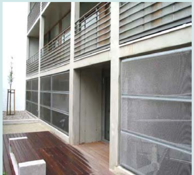
rotec-Streckgitter als Balkonverkleidung sowie Wandverkleidung eingefasst im Einfassprofil Typ E aus Edelstahl 1.4301
