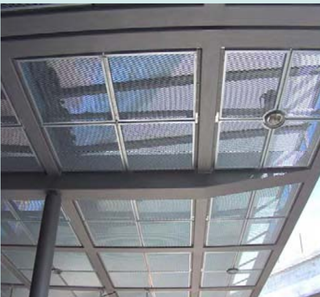
rotec-Streckgitter als Deckenverkleidung im Winkelprofil eingefasst und nachträglich feuerverzinkt
