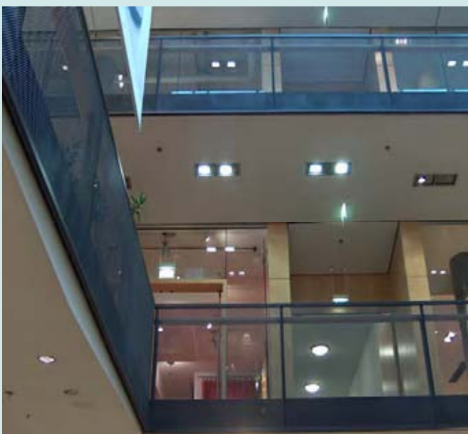
rotec-Streckgitter mit Quadratmasche, eingefasst im Rahmenprofil als Geländerfüllung und nachträglich pulverbeschichtet
