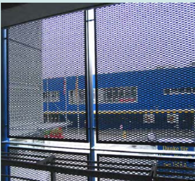
rotec-Streckgitter als Fassadenverkleidung eines Parkhauses eingefasst im Winkelrahmen und nachträglich pulverbeschichtet
